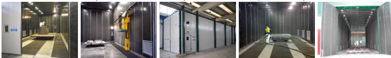
Collocazione interno fabbricato con raschiatori e coclea
